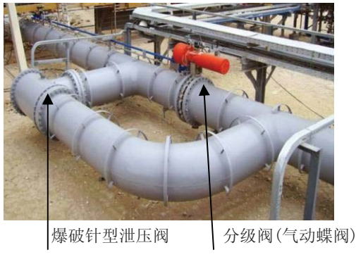
图 1 爆破针型泄压阀作为地面火炬的安全泄放旁路
